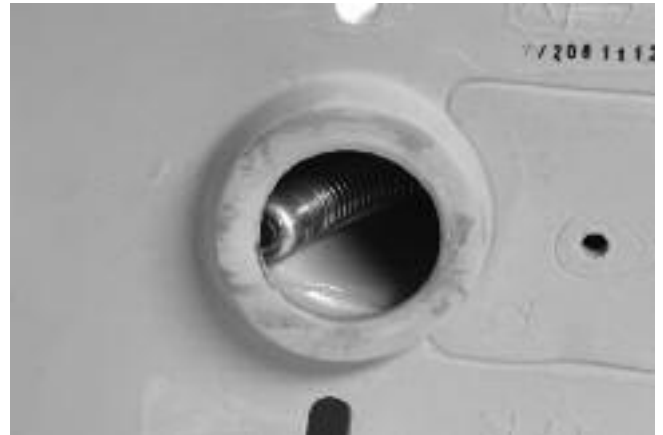
Abbildung 20 – Kamerakopf in der Wendung blockiert
