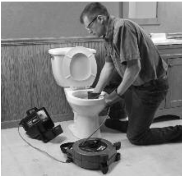
Abbildung 15 – Durchführung einer Inspektion
