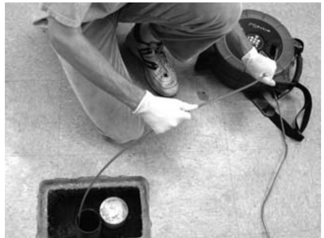
Abbildung 28 – Richtige Technik für das Zurückschieben des Kabels in die Trommel
