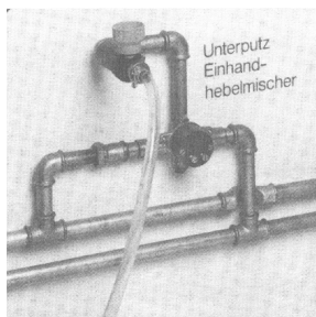
Esempio di montaggio: Lavaggio di miscelatori a leva incassati.
