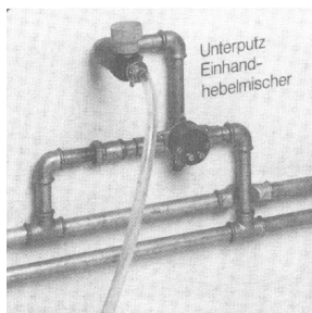
Пример установки: Промывка рычажного смесителя под штукатуркой, управляемого одной рукой.
