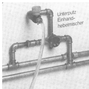
Exemple de montage: Rinçage de mitigeurs sous crépi.
