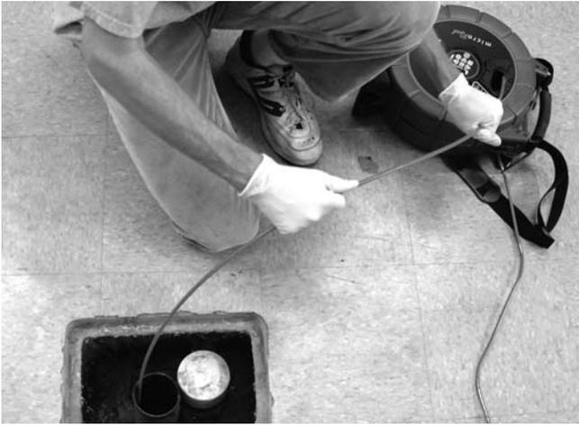
Figure 28 – Manière appropriée de rembobiner le câble d'avancement dans le tambour
