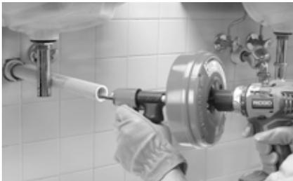
**Abbildung 7 – Beispiel fur die Verlangerung der Abflussoffnung auf einen Abstand von 4" (100 mm) zur Abflussoffnung**
