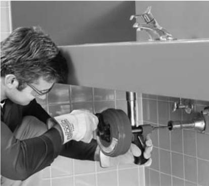
**Abbildung 8 – Power-Spin manuell eingesetzt**
