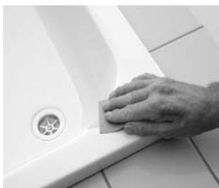
**Lors de la réparation de d'acrylique ou du fibreglass, il convient de prendre en compte les différences suivantes:** Dans ces cas l'enduit ne peut servir qu'à boucher les éclatements et les rayures profondes. Les fissures de contrainte et les endroits fracturés ne peuvent **pas** être recollés. Poncez proprement l'endroit rebouché au moyen du papier abrasif humide 800 **gris** en utilisant de l'eau.
