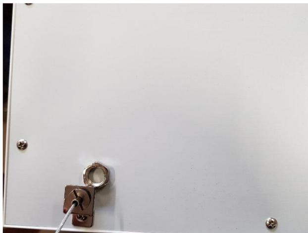
*Abbildung 4: Abhängeseil am Z-Winkel befestigen*
